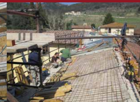
Mars 2015 : pose de la chape et de l'étanchéité
