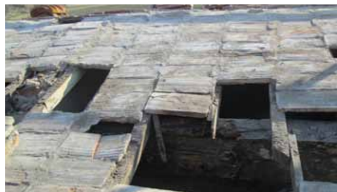
État des toits lorsque les tuiles ont été retirées. On aperçoit la poutre principale, fortement attaquée par les infiltrations. Photo de droite, le toit refait avec une partie des tuiles anciennes ; on aperçoit à gauche l'étanchéité posée sous les tuiles.
