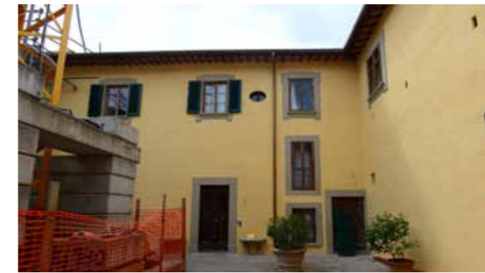
Il cortile interno al momento del montaggio delle impalcature e dopo il restauro. Si vedono i blocchi di cemento che mantengono la base della gru: il peso di ognuno d'essi varia fra 800 e 2500 kg per i più lunghi.
