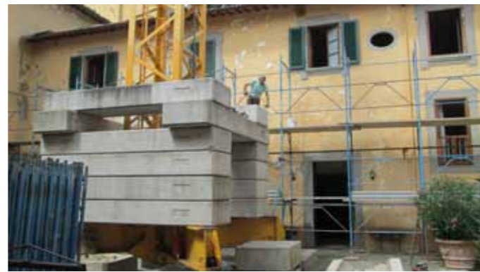
Il cortile interno al momento del montaggio delle impalcature e dopo il restauro. Si vedono i blocchi di cemento che mantengono la base della gru: il peso di ognuno d'essi varia fra 800 e 2500 kg per i più lunghi.
