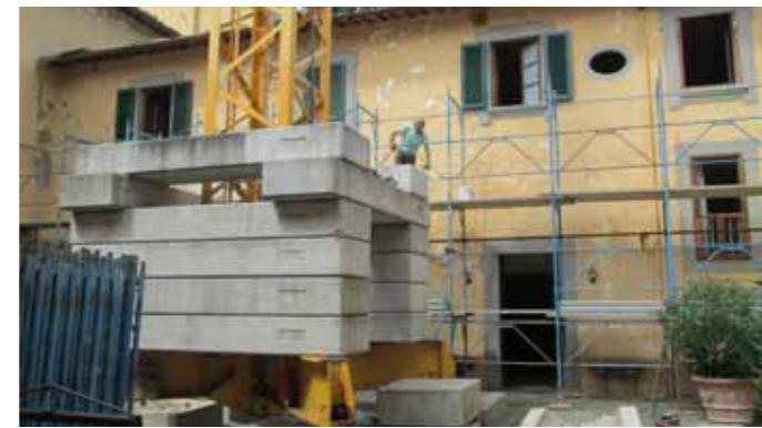
Il cortile interno al momento del montaggio delle impalcature e dopo il restauro. Si vedono i blocchi di cemento che mantengono la base della gru: il peso di ognuno d'essi varia fra 800 e 2500 kg per i più lunghi.
