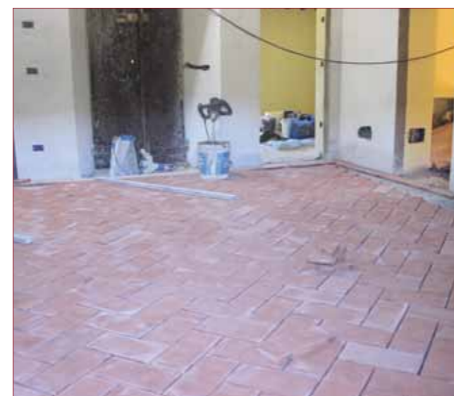
Perché tutto il terreno franava, i pavimenti sono stati interamente rifatti.
