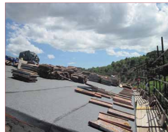
Lavori sul tetto della casa colonica.
