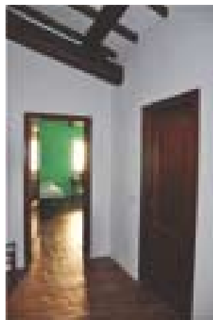
Un corridoio completamente rinnovato: due stanze si sono potute così ricavare dove prima non c'era nulla.
