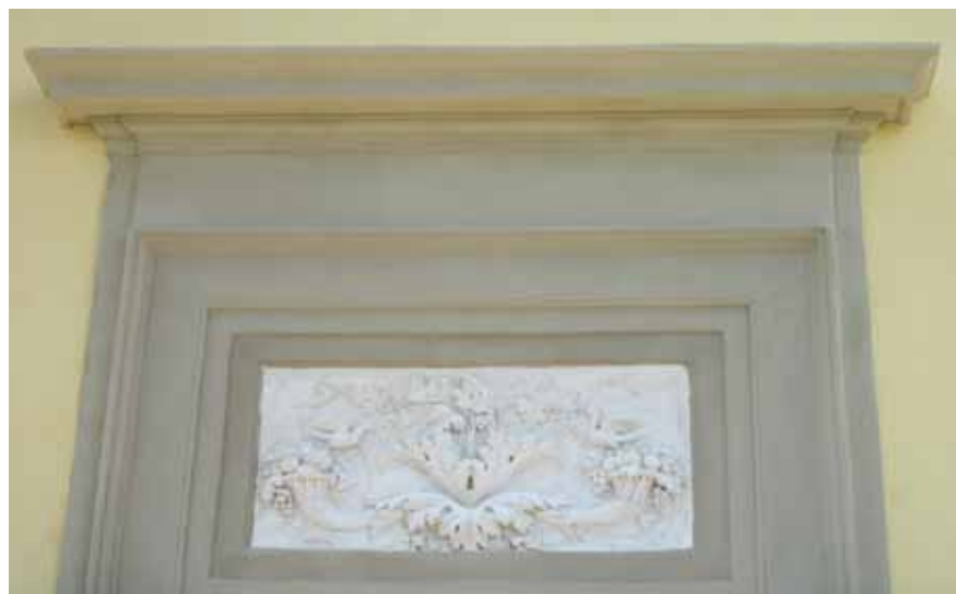
Détails de la façade sud, soigneusement restaurée.
