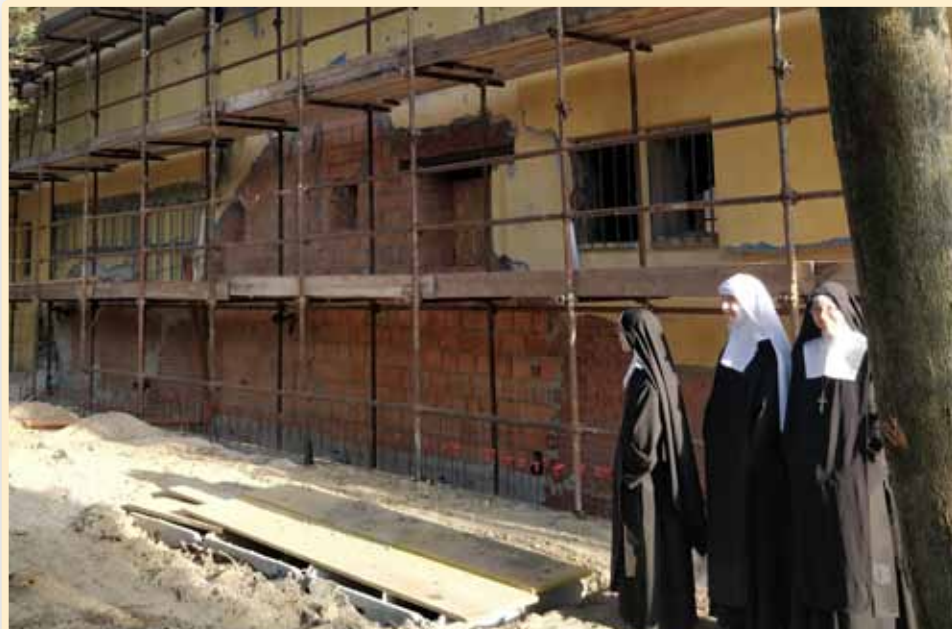
La facciata nord: possiamo vedere le nuove fondazioni
