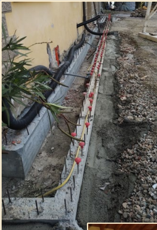
Création de nouvelles fondations pour éviter un effondrement
