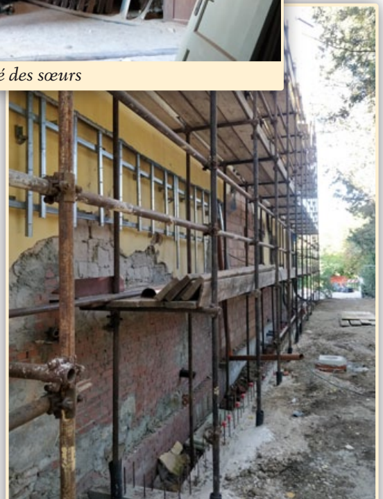
La façade nord
