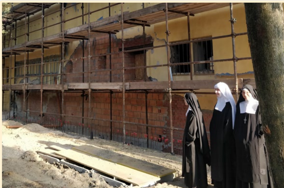
La façade nord : on aperçoit les nouvelles fondations
